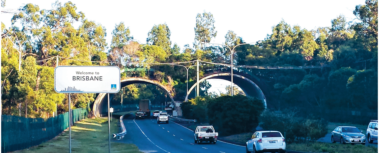
Djurbron mellan naturreservaten Karawatha Forest och Kuraby Bushland i Brisbane, Australien, möjliggör en ekologisk länk och är en av fyra olika sorters viltpassager som prövas tillsammans med viltstängsel för att hindra djuren från att komma ut på motorvägen. (Bild från Medströms Förlag.)
